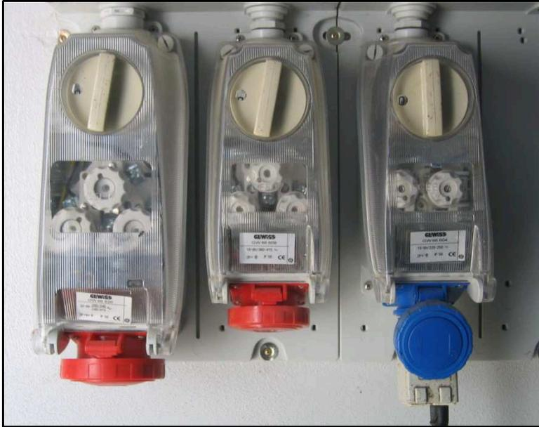
dotate di interblocco per l'inserimento o il disinnesto della spina nella presa solo con alimentazione interdetta
